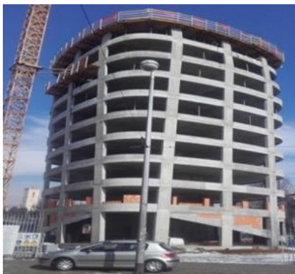
Slika 29. Građevina za smještaj na Hrvatskom vojnom učilištu „Dr. Franjo Tuđman“
