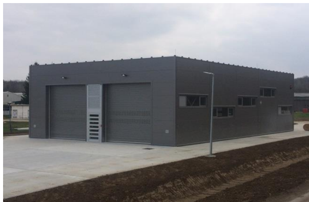
Tehnička građevina – pralište
