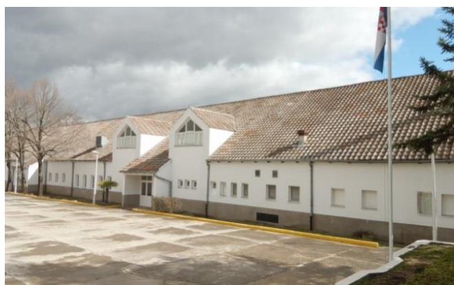
Slika 32. Renovirana Vojarna „126. brigade HV“
