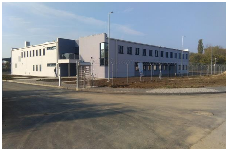
Slika 24. Građevina razmjestivoga komunikacijskog modula
