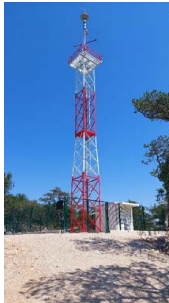
Slika 5.4. Kontrolno-mjerna postaja Osorščica
