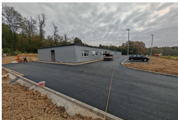
Slika 18. Višenamjenska građevina u vojarni „Pukovnik Milivoj Halar“ u Dugom Selu
