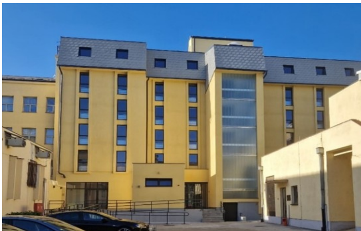
Slika 20. Cjelovita obnova građevine u Ulici Antuna Bauera 33 u Zagrebu
