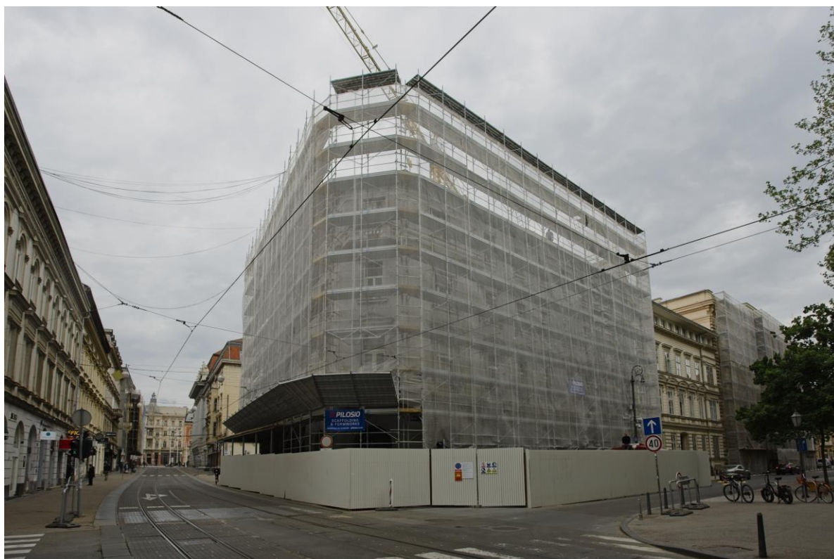
Konstrukcijska obnova višestambene zgrade Zrinjevac 1, Zagreb
