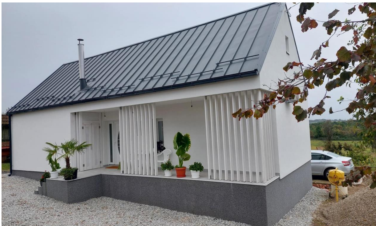
Zamjenska obiteljska kuća u Donjoj Bačugi (tipska)
