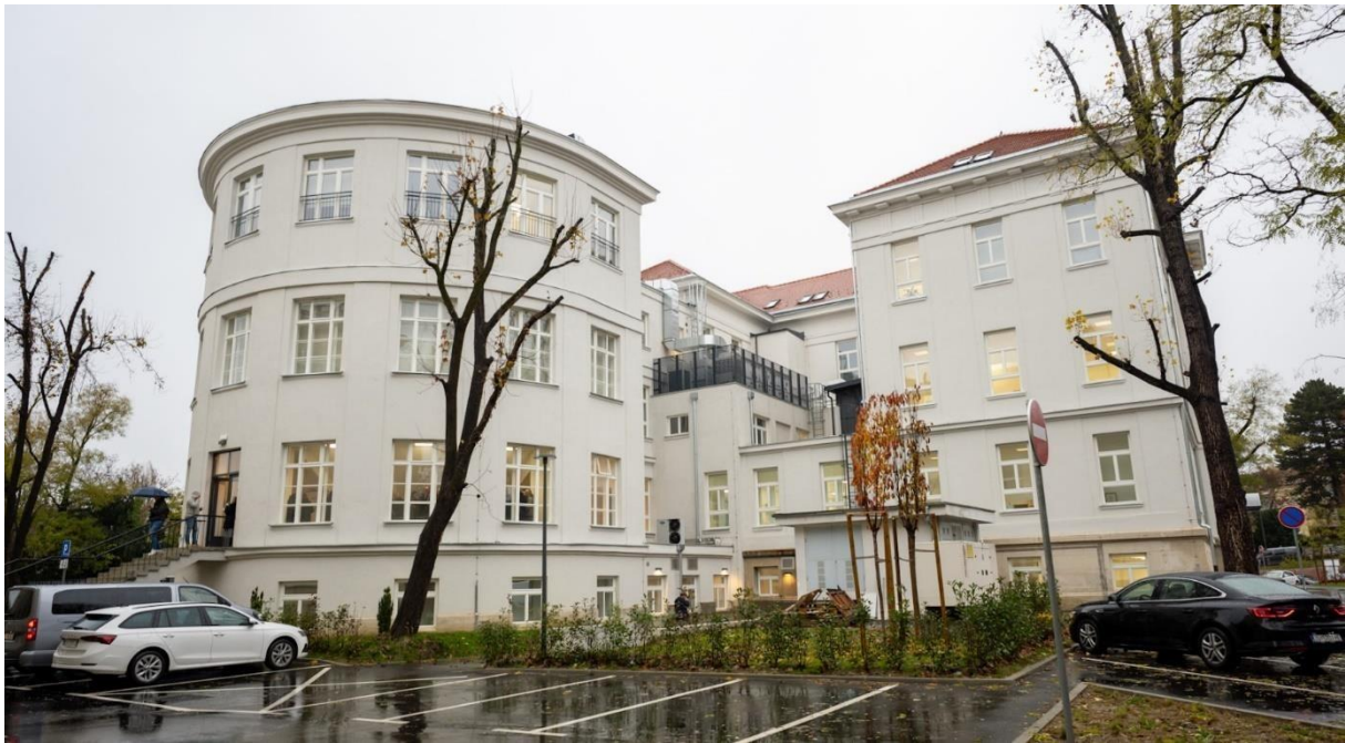
Obnovljena zgrada HZJZ-a u Zagrebu
