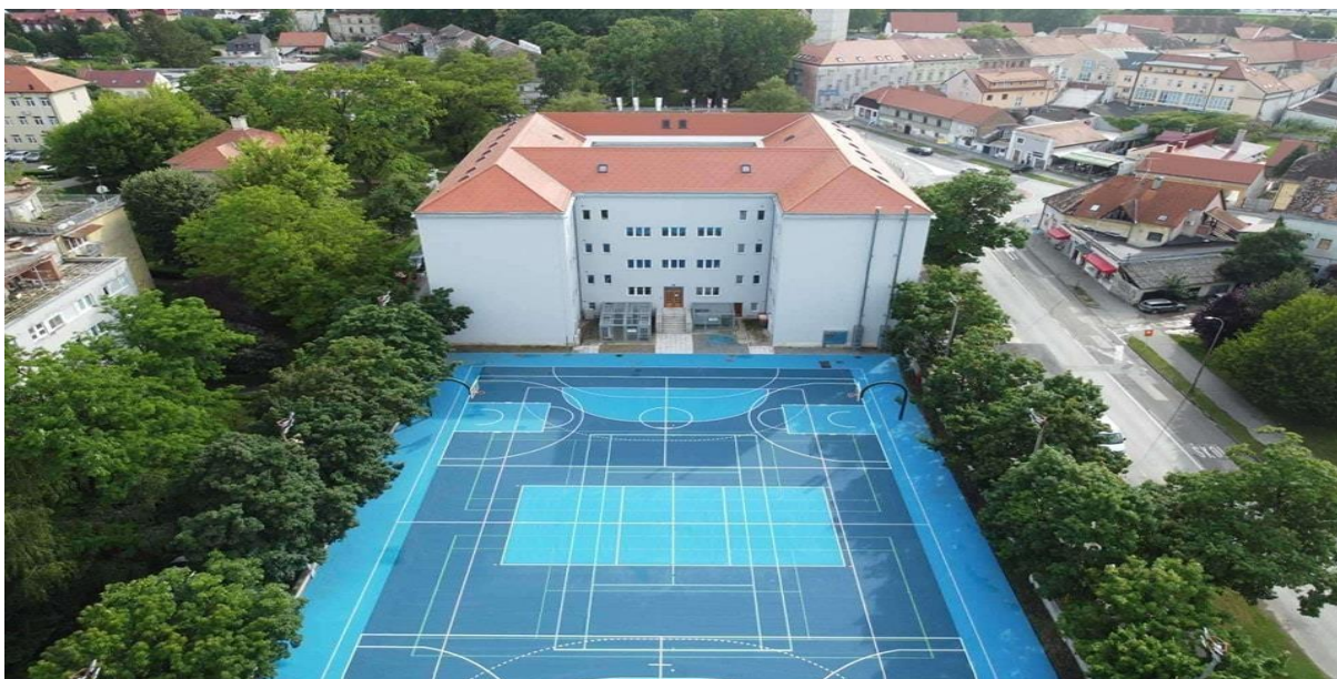
Obnovljena Gimnazija Sisak
