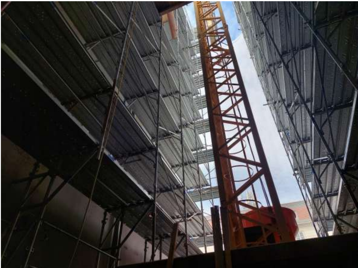
Konstruktivska obnova višestambene zgrade Zrinjevac 1, Zagreb
