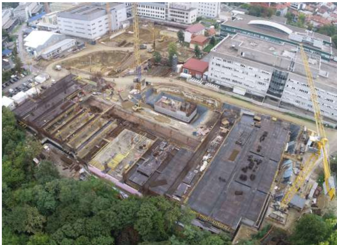
Radovi na KBC-u Zagreb - Rebro
