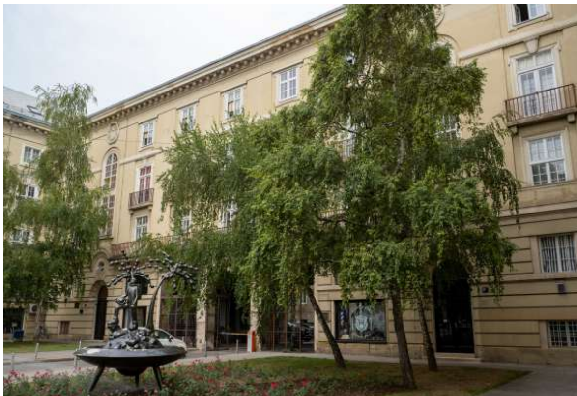
Blokovska obnova – Mali Vatikan, Zagreb
