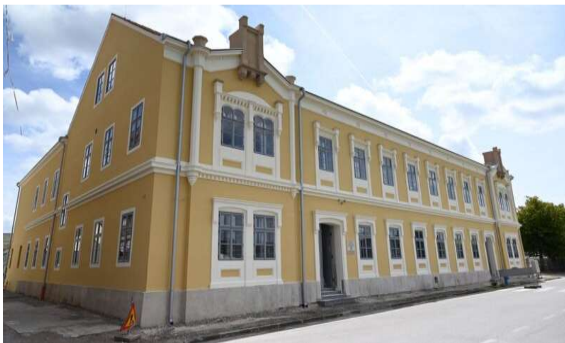
Obnovljena Prva osnovna škola Petrinja
