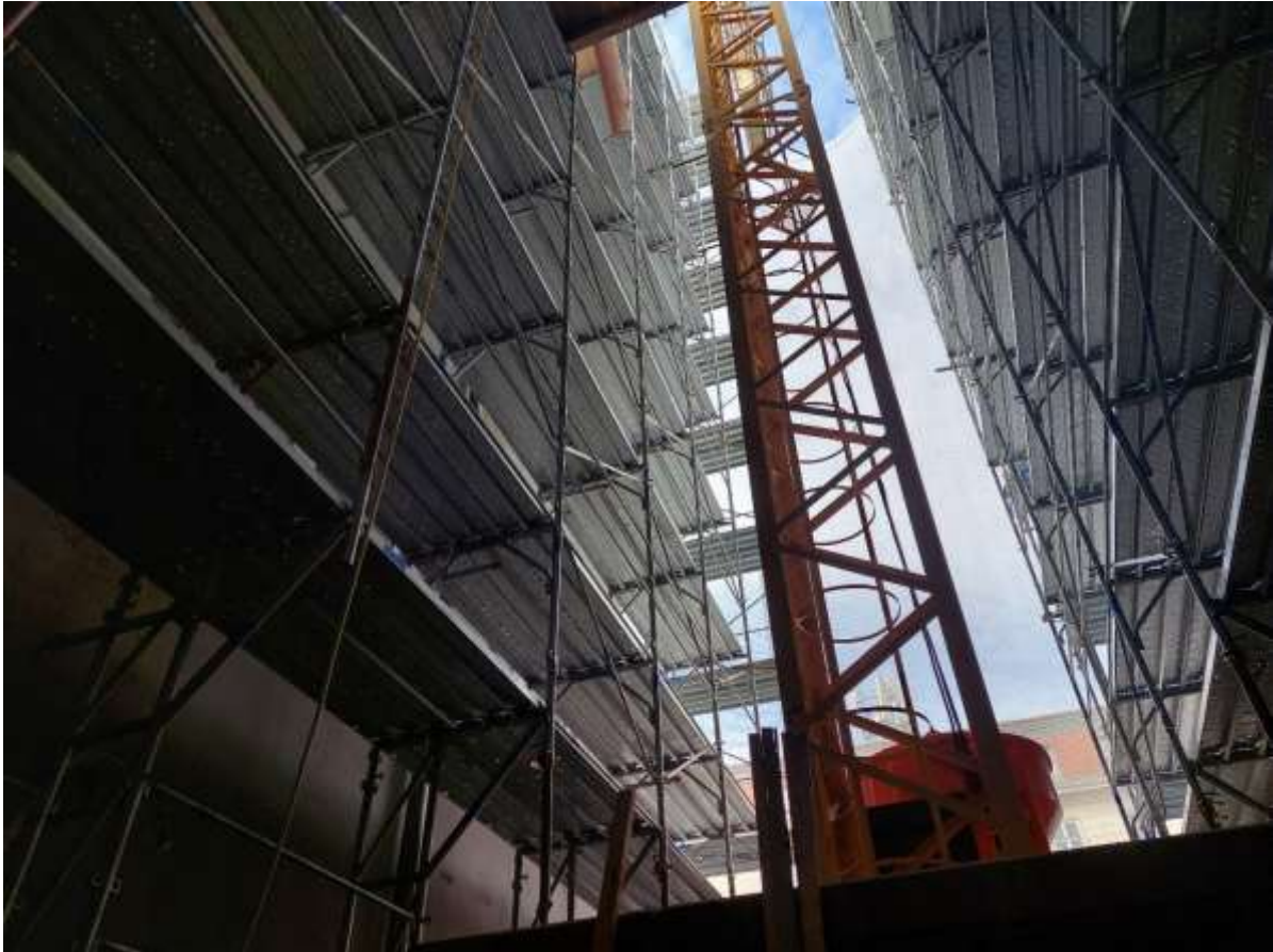
Konstruktivska obnova višestambene zgrade Zrinjevac 1, Zagreb
