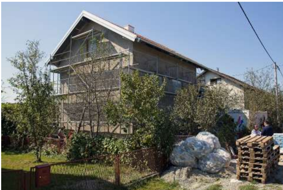
Nekonstrukcijska obnova kuće s energetsom obnovom u Glini
