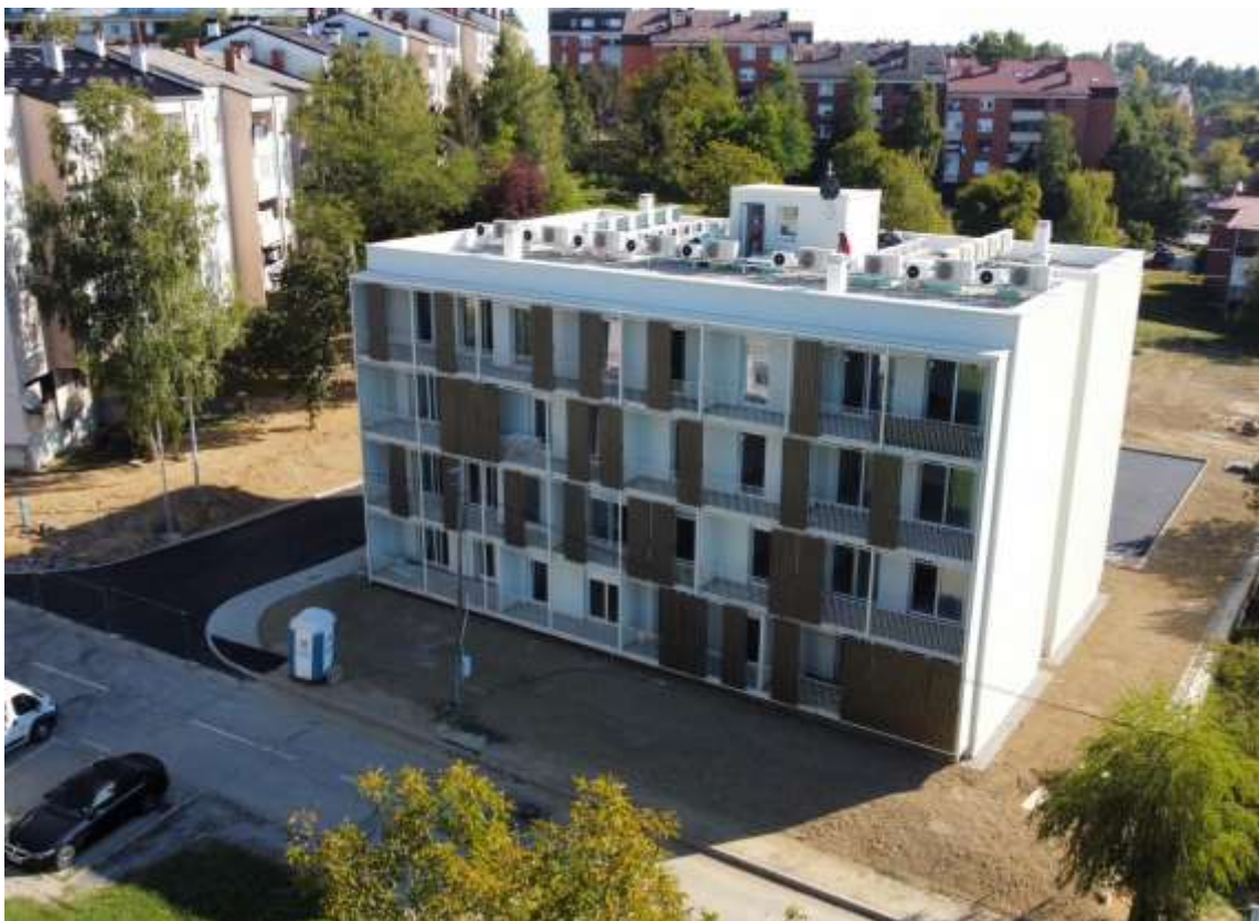
Izgradnja višestambenih zgrada - tipskih
