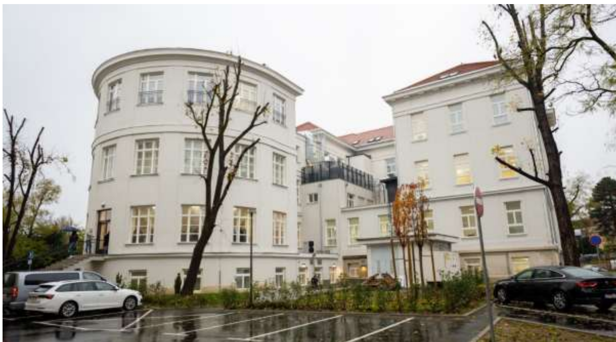
Obnovljena zgrada HZJZ-a u Zagrebu
