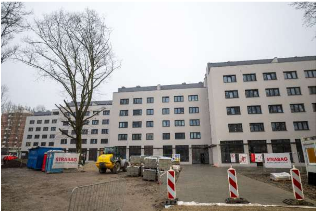
Blokovska obnova – Ulica Hrvatskog narodnog preporoda, Sisak
