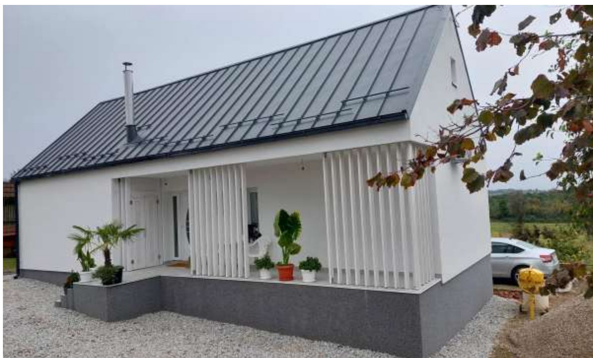
Zamjenska obiteljska kuća u Donjoj Bačugi (tipska)
