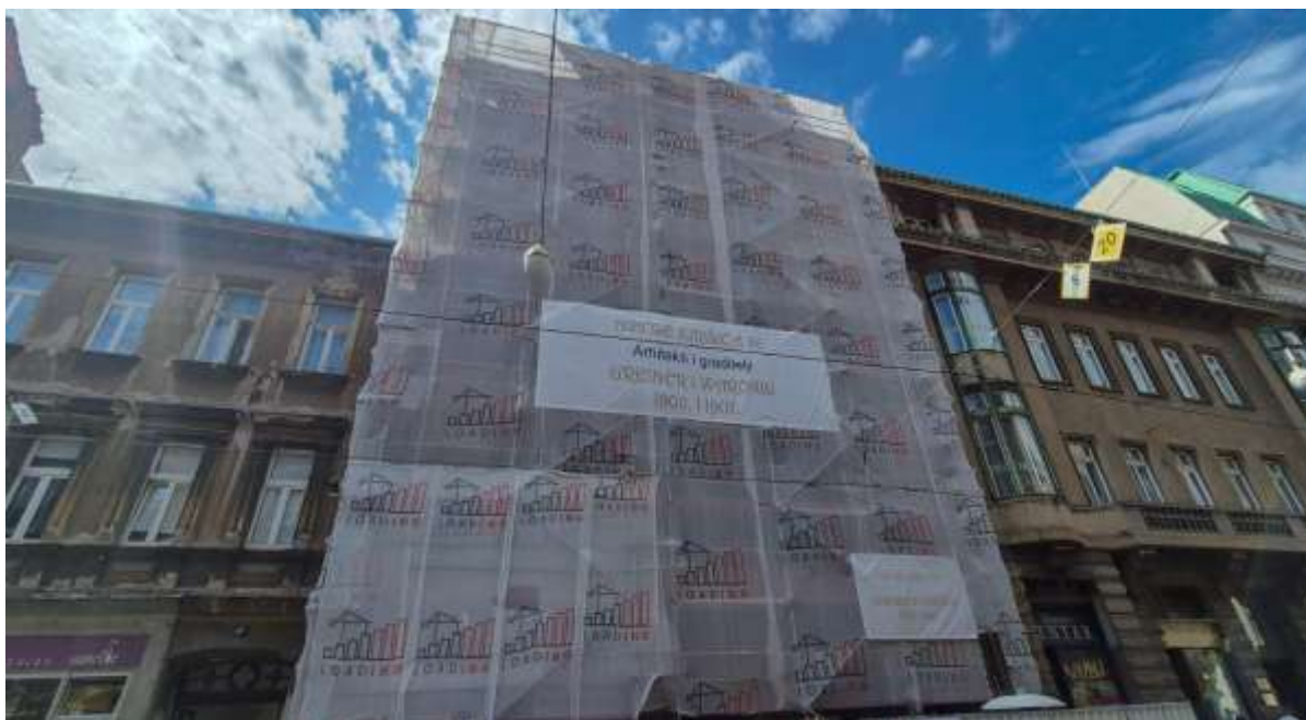
Konstruktivska obnova višestambene zgrade u Jurišićevoj ulici, Zagreb
