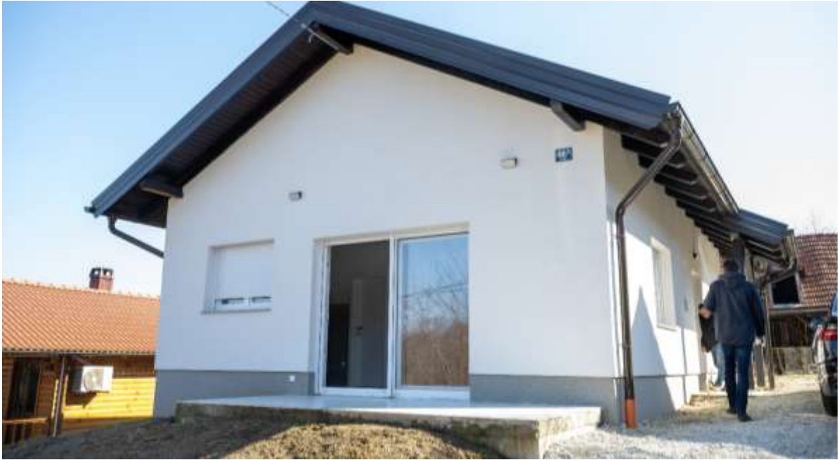
Zamjenska obiteljska kuća u Zagrebu
