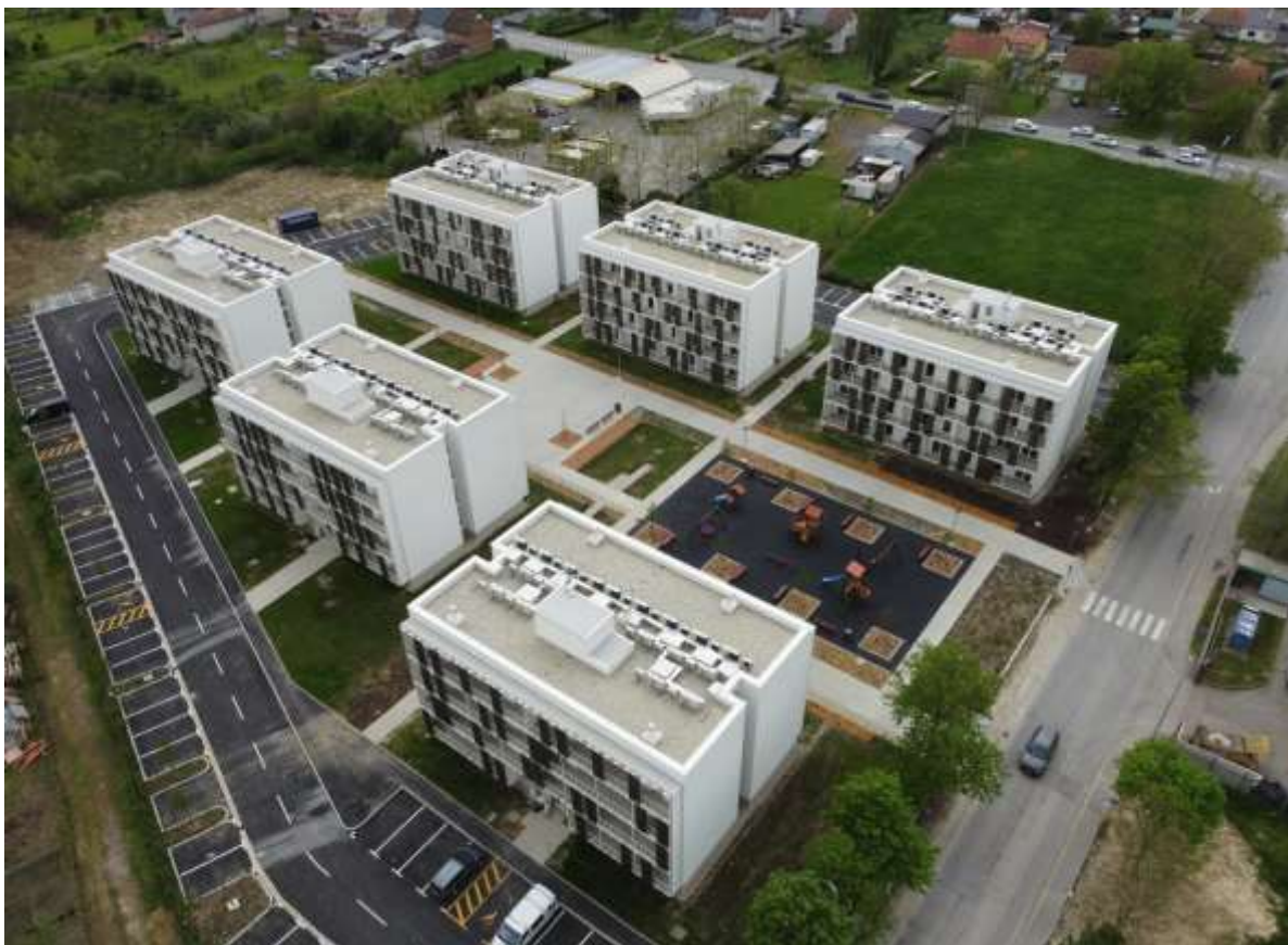
Šest novoizgrađenih zgrada u Capraškaj ulici, Sisak
