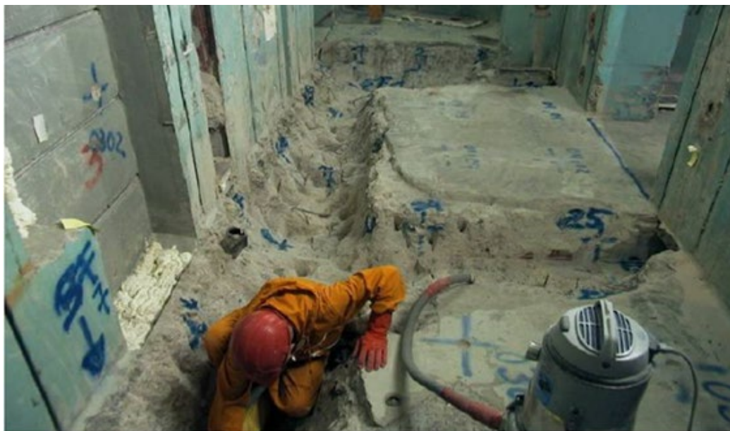
Slika 5-24: Uklanjanje dublje kontaminacije
