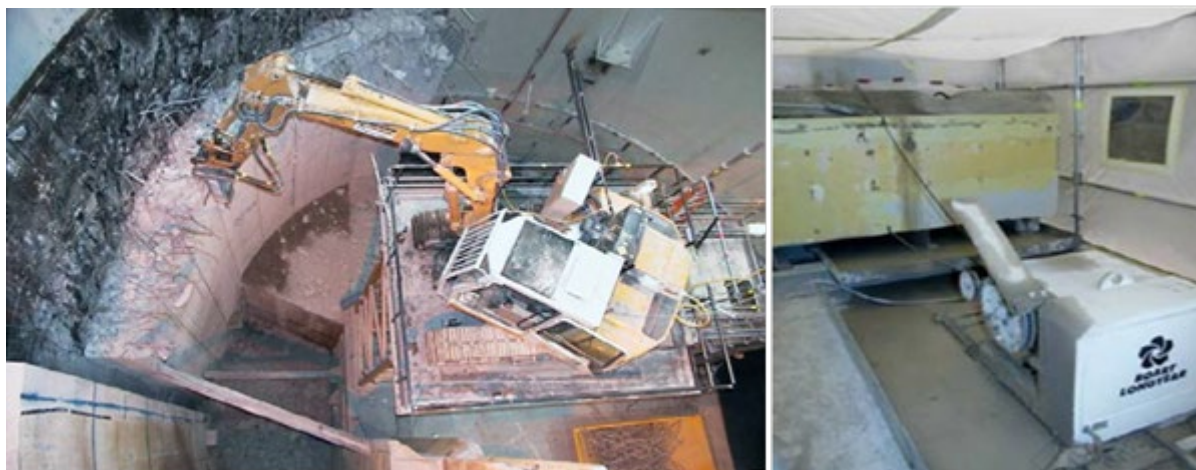
Slika 5-25: Uklanjanje velikih količina: lijevo bager, desno čelično uže
