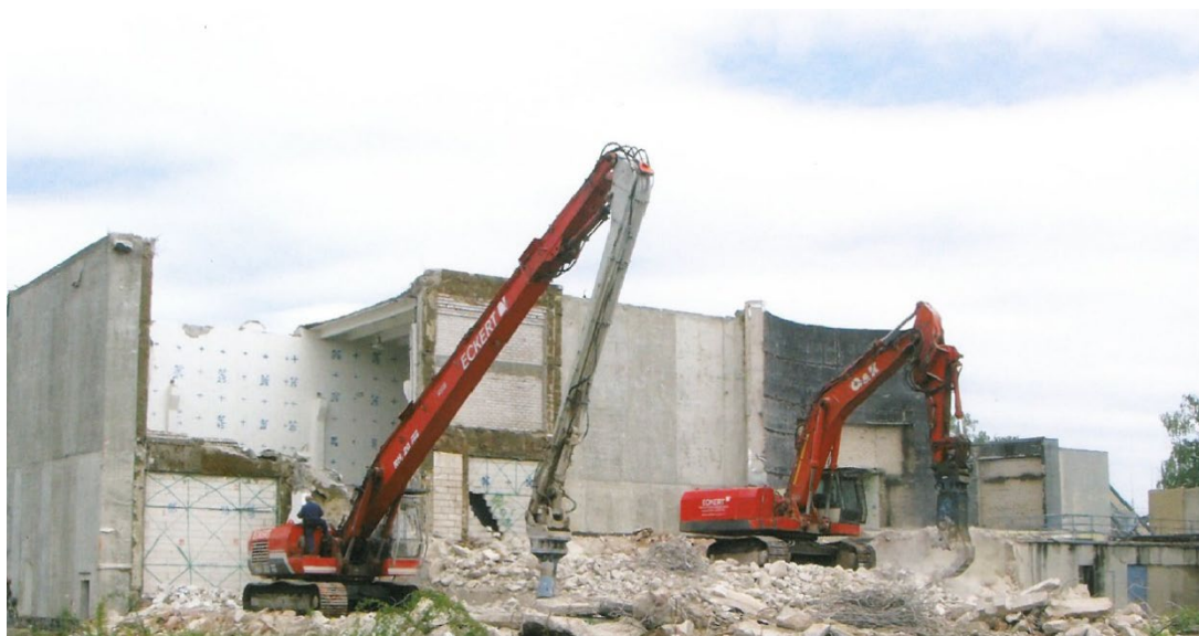
Slika 5-28: Konvencionalno rastavljanje građevinskih konstrukcija
