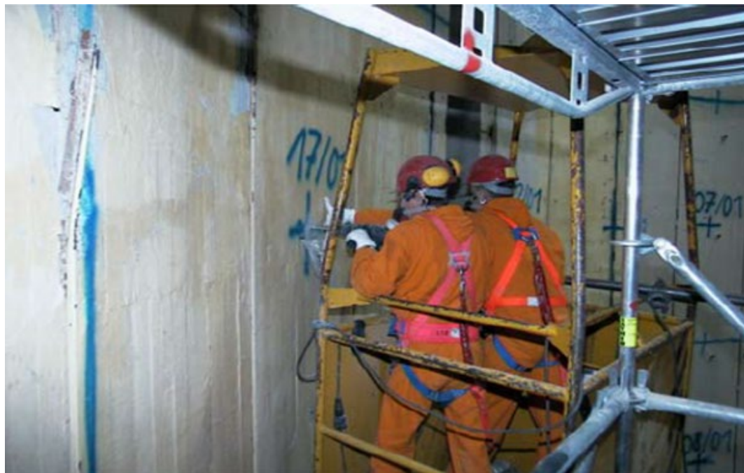
Slika 5-23: Priprema za skarifikaciju: skidanje cilindričnih zatika
